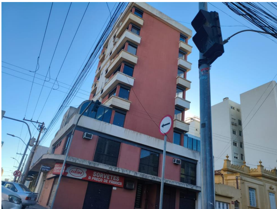
Foto 1: Fachada frontal do imóvel – Rua Dom Pedro II
